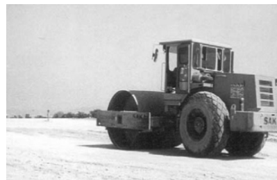
Paving Top Layer
